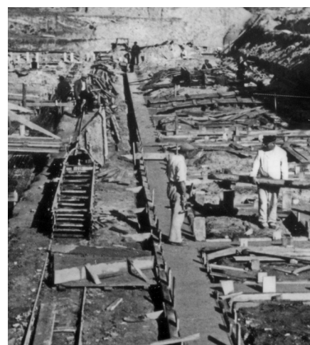
Die Baugrube für den Neubau unserer Kinder- und Jugendklinik. Der Grundstein wurde 1938 gelegt - komplett fertiggestellt war der Bau 1953.
