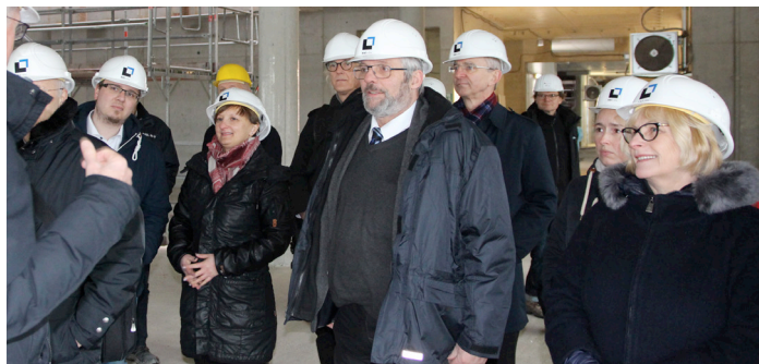
15 Abgeordnete, Fraktions- und Ausschussmitglieder sowie Vertreter des Finanzministeriums besichtigten die Großbaustelle des neuen Zentralgebäudes
