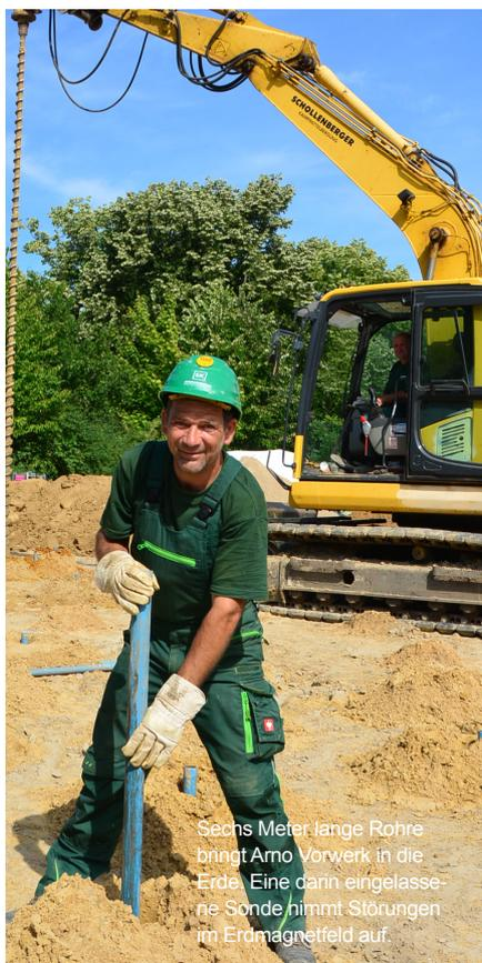
Sechs Meter lange Rohre bringt Arno Vorwerk in die Erde. Eine darin eingelassene Sonde nimmt Störungen im Erdmagnetfeld auf.
