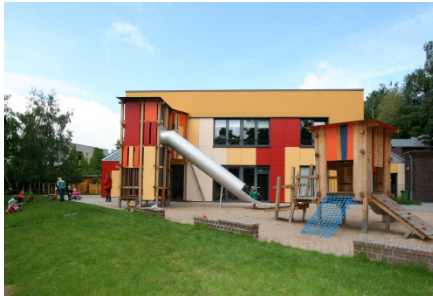
Der Betriebskindergarten „Gewächshaus“ wird über eine Wärmepumpe versorgt.
