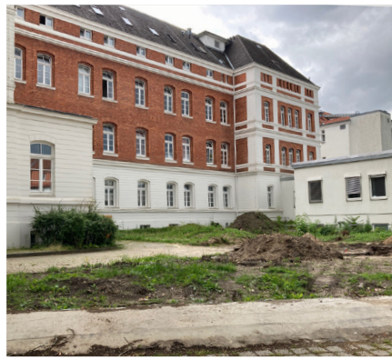
Hinter der Augenklinik entsteht ein Anbau für einen Aufwachraum.
