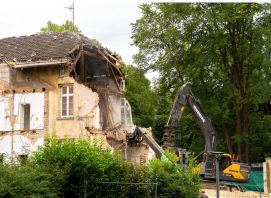
Abriss des alten Psychiatriegebäudes in Gehlsdorf. Dort wird interimweise ein Container für Büros aufgestellt
