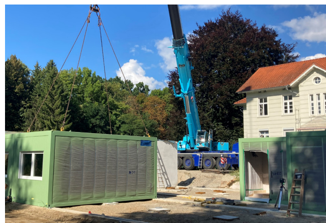
Die psychiatrische Tagesklinik und Büroräume werden in dem Modulgebäude untergebracht.
