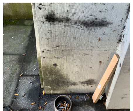
Die Bausubstanz wird beschädigt, wenn Zigaretten achtlos liegengelassen, in Rillen gequetscht oder an der Gebäudefassade ausgedrückt und dann fallen gelassen werden.
